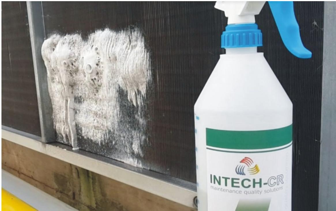
Il **DBF** è un detergente super concentrato ad alta alcalinità idoneo per la detergenza e la disossidazione delle batterie di scambio termico delle unità esterne. Idoneo sia su unità esterne di impianti di condizionamento, di refrigerazione e su evaporatori di celle frigo. La sua capacità bagnante con effetto schiumogeno ritardato permette di aggredire le impurità, anche in profondità, riportando i pacchi alettati alle condizioni originali ripristinando un ottimale scambio termico.
